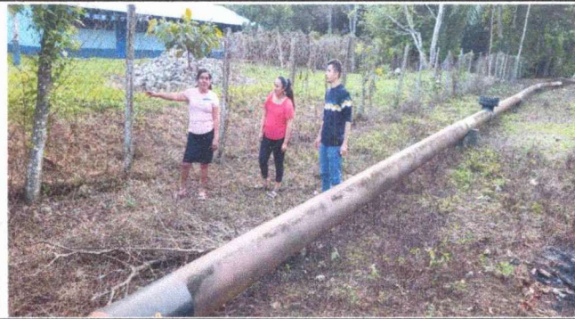
Foto 1: EN LA FOTOGRAFIA SE PUEDE OBSERVAR PARTE DE LA CIRCULACION EN MUY MAL ESTADO.
