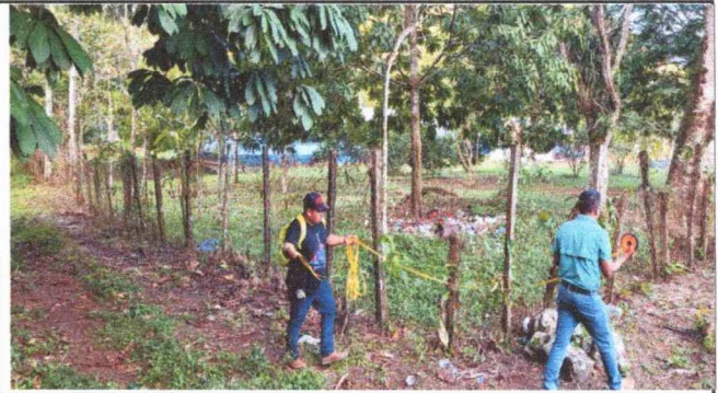
Foto 4: MEDICION DEL PERIMETRO DEL MURO PERIMETRAL EN MAL ESTADO PARA DETERMINAR LA CANTIDAD DE MATERIALES A UTILIZAR.
